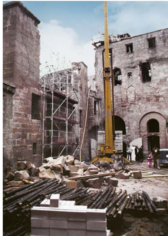
Abb. 3 ■ Wiederaufbau der Kernburg
