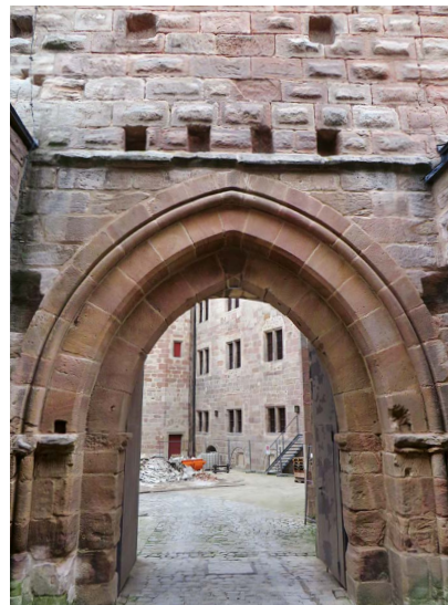
Abb. 6 ■ Portal der Cadolzburg mit sekundären Balkenlöchern
