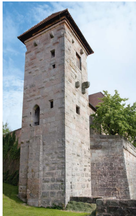
Abb. 7 ■ Hungerturm am Rande der Vorburg, erbaut um 1470
