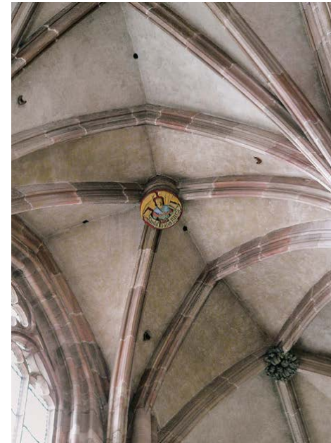
Abb. 24 ■ Spätgotisches Gewölbe im Chorumgang von St. Lorenz, Nürnberg, mit Detailausschnitt eines Schlusssteins mit Rippenprofilen
