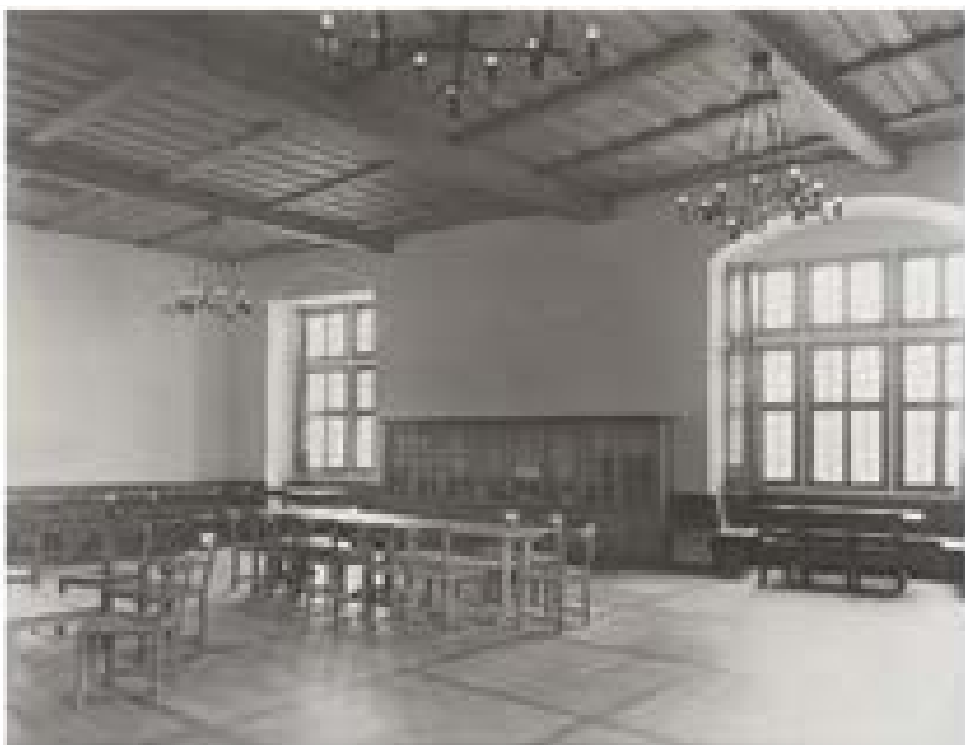
Abb. 16 und 17 ■ Innenaufnahmen der HJ-Gebietsführerschule im Neuen Schloss der Cadolzburg, um 1938 (StAN, NS Mischbestand HJ 7)
