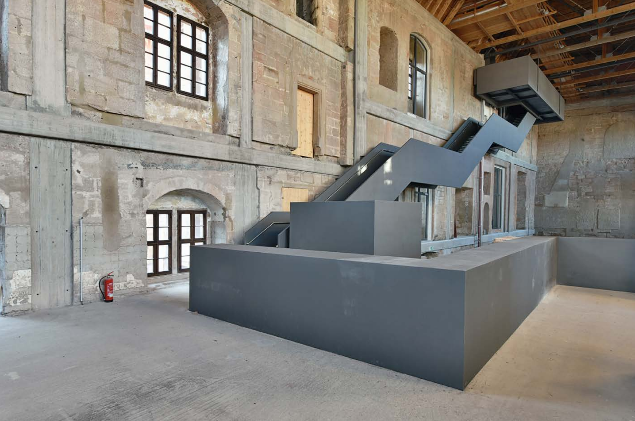
Abb. 5 ■ Blick auf die neu eingebrachte Treppe im Neuen Schloss
