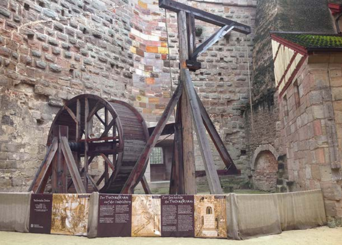
Abb. 2 ■ Der Tretkran im Innenhof der Cadolzburg nach Plänen von Elias Holl
