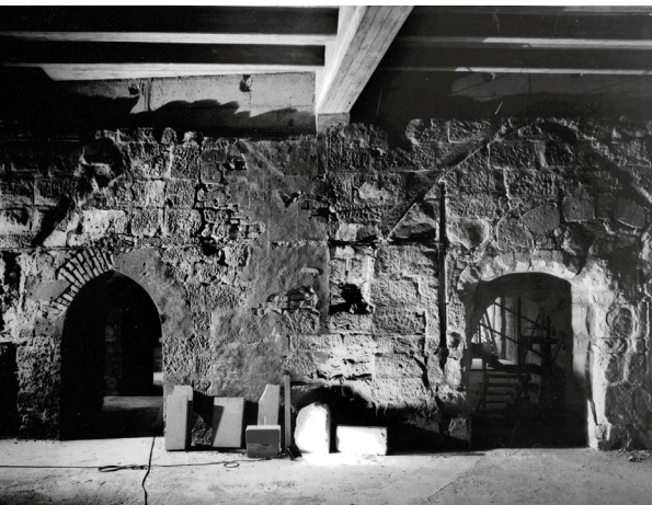
Abb. 13 ■ Ritzlinien der Schildbögen, Streifenlichtaufnahme der Nordwand des Erkersaals, 1997, Befundbericht Reichelt (BSV, München, Bauarchiv, D-CA 01/04/009)
