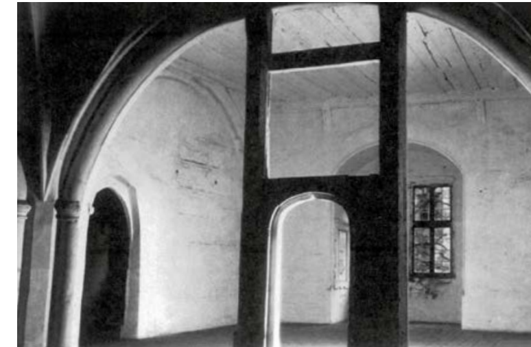
Abb. 15 ■ Spitz zulaufende Anfänger am Mittelpfeiler des Sterngewölbes (li.) mit angedeuteten Kapitellen an den Gurtbögen, Zustand 1936 (BLFD, München)
