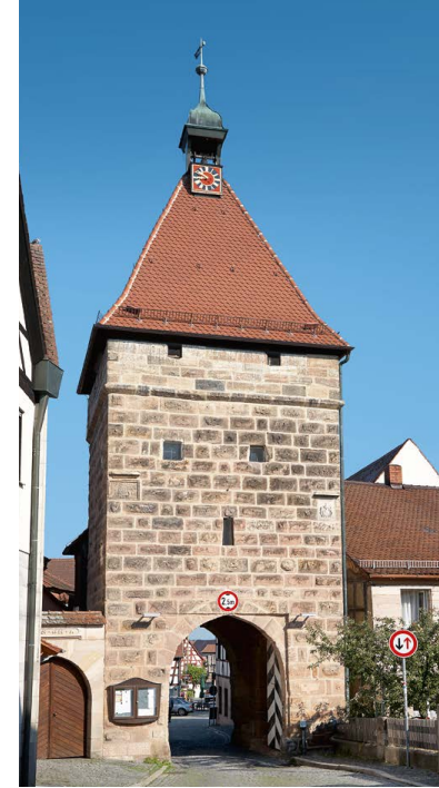
Abb. 6 ■ Das spätmittelalterliche Tor der Marktbefestigung
