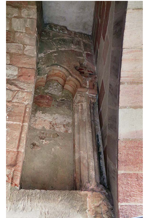
Abb. 10 ■ Biforenfenster in der westlichen Palaswand
